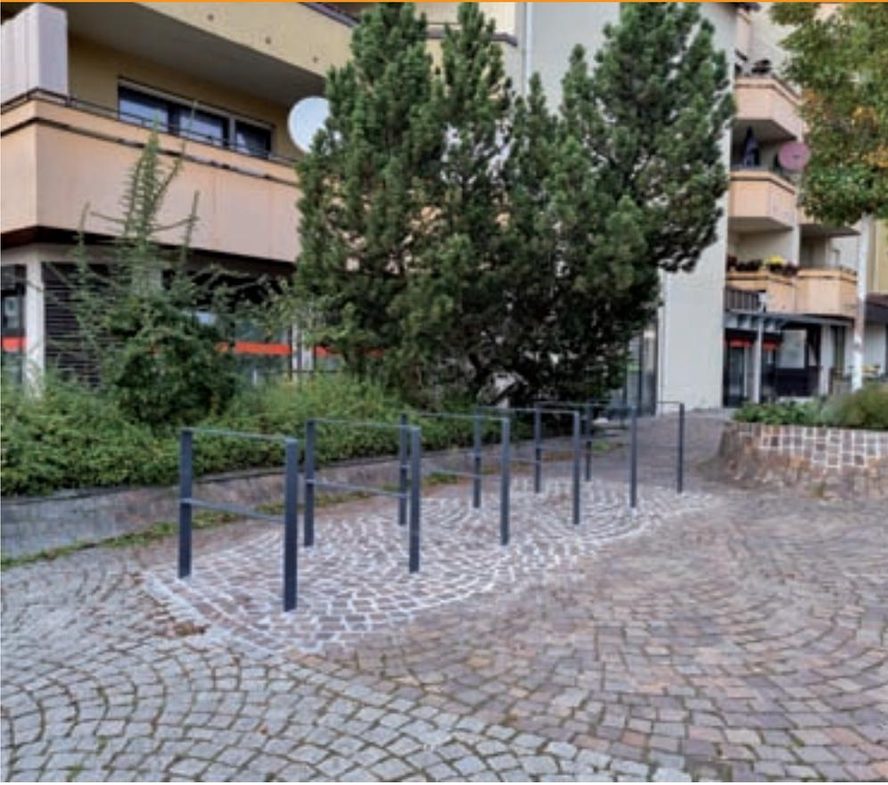
Um den Fahrradfahrern das abschließbare Abstellen Ihrer Fahrräder am Marktplatz zu ermöglichen, wurden im Oktober an der Südwestecke des Marktplatzes sechs Fahrrad-Anlehnbügel aus verzinktem, pulverbeschichtetem Stahl montiert. Einer Ruhepause während der Fahrradtour, verbunden mit Einkauf- und Verweilmöglichkeit im Herzen Salachs steht somit nichts mehr im Wege.
