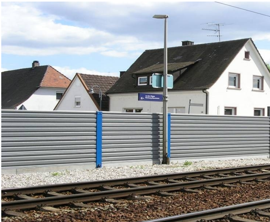
Beispiel für eine 2 m hohe Wand in einer anderen Gemeinde. Für Salach sind Wände der gleichen Bauart vorgesehen.
